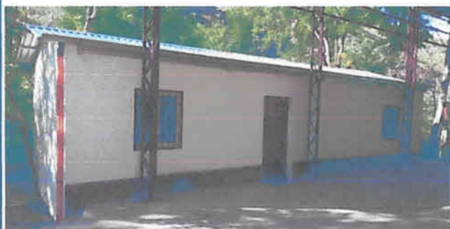
Foto 3: Finalización de techo, ventanas y repello
