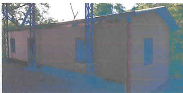
Foto 6: Finalización de la obra
