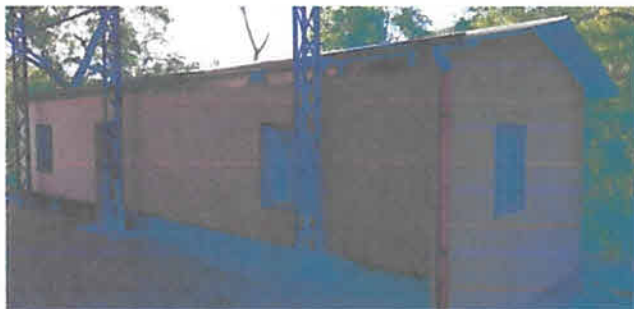
Foto 1: Instalación de ventanas
