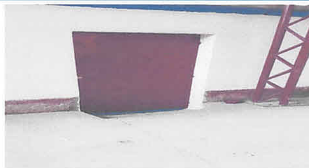
Foto 4: Instalación de puerta
